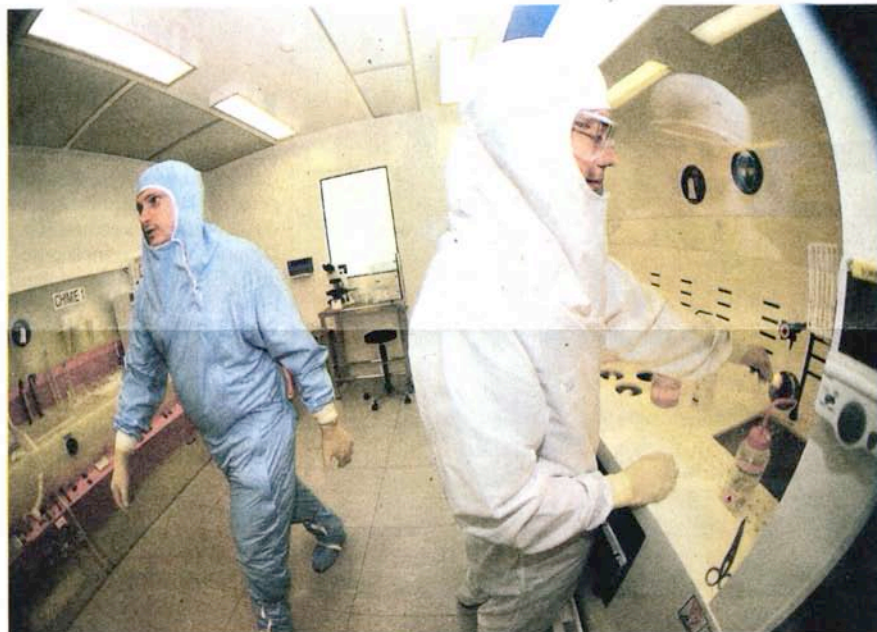
Le pôle chimie: une des structures en épi de la salle blanche. Au fond, la vitre en plexiglas auto-cassante permet une évacuation rapide en cas d'incident. Photo DDM, Rémy Gabalda.
